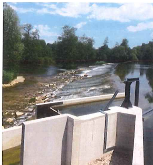
Le barrage réaménagé
